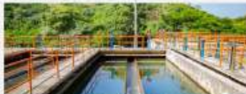
Construcción de la Red para el Abastecimiento de Agua Potable, Santa Marta (mil millones)
