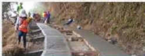
Construcción de Placa Huella Palmor a Makenkal en el Municipio de Ciénaga (4 mil millones)
