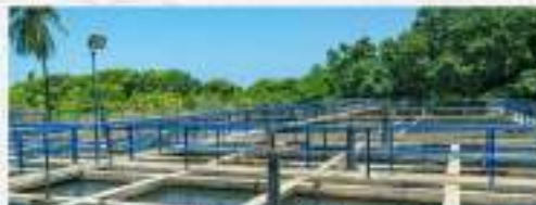
Instalación de Línea de Conducción de Agua Potable de 6 Pulgadas en Ciénaga (408 millones)
